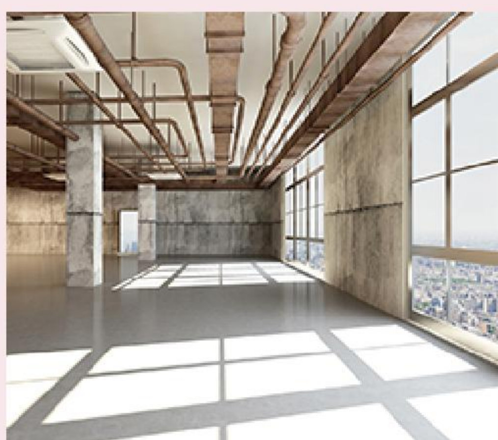
1- 上门考察场地 1. Site inspection
